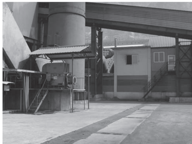
承德铜兴矿业有限责任公司球团厂安装现场
